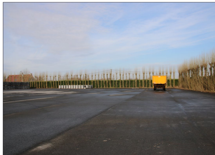
ZICHT OP HET NOORDELIJKE DEEL VAN DE BEDRIJFSSITE
