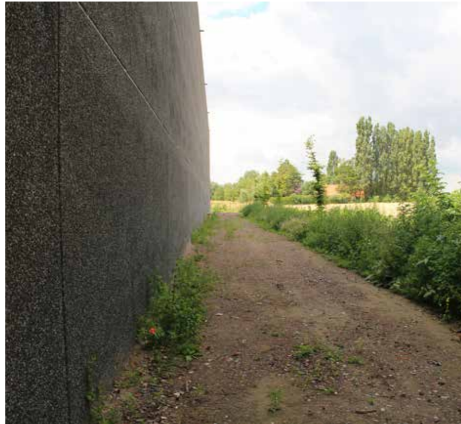
7. ZICHT OP DE NIEUWE LOODS EN OMRINGENDE LANDSCHAP
