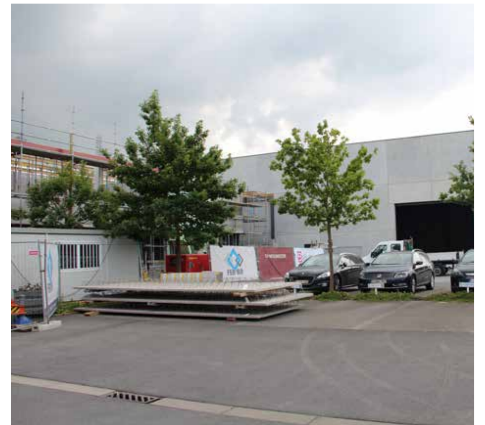
4. ZICHT OP HET NIEUWE KANTOORGEBOUW EN DE NIEUWE LOODS
