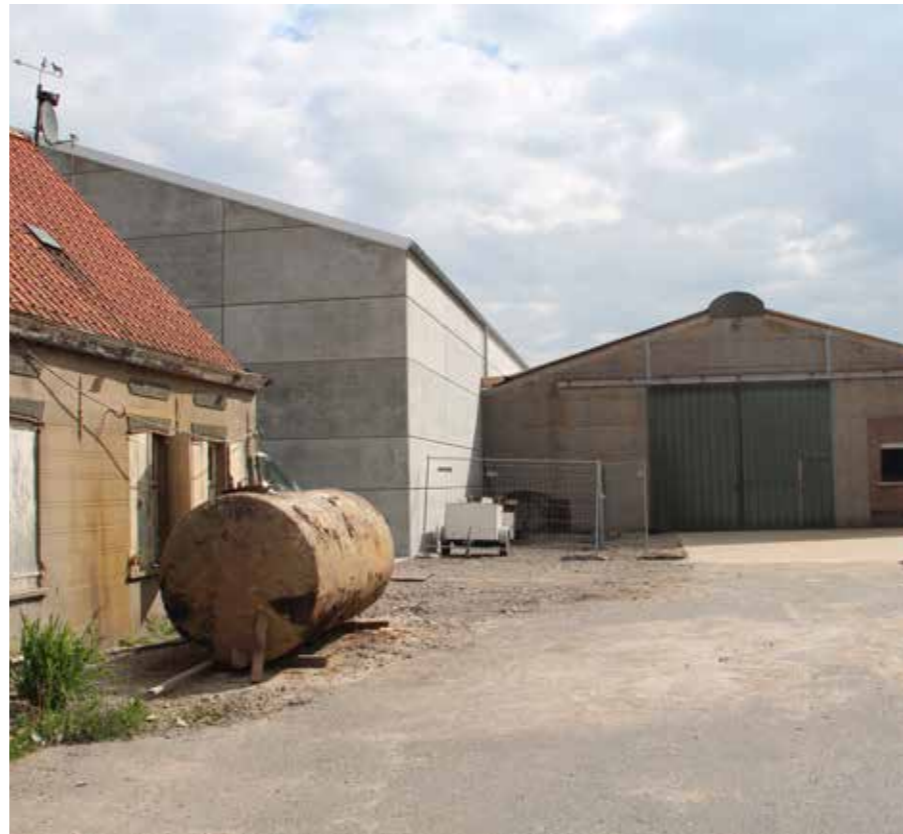
1. ZICHT OP DE OUDE HOEVE, DE NIEUWE LOODS EN DE OUDE LOODS
