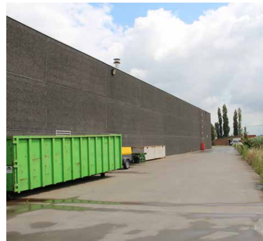
4. ZICHT OP DE OUDE LOODS
