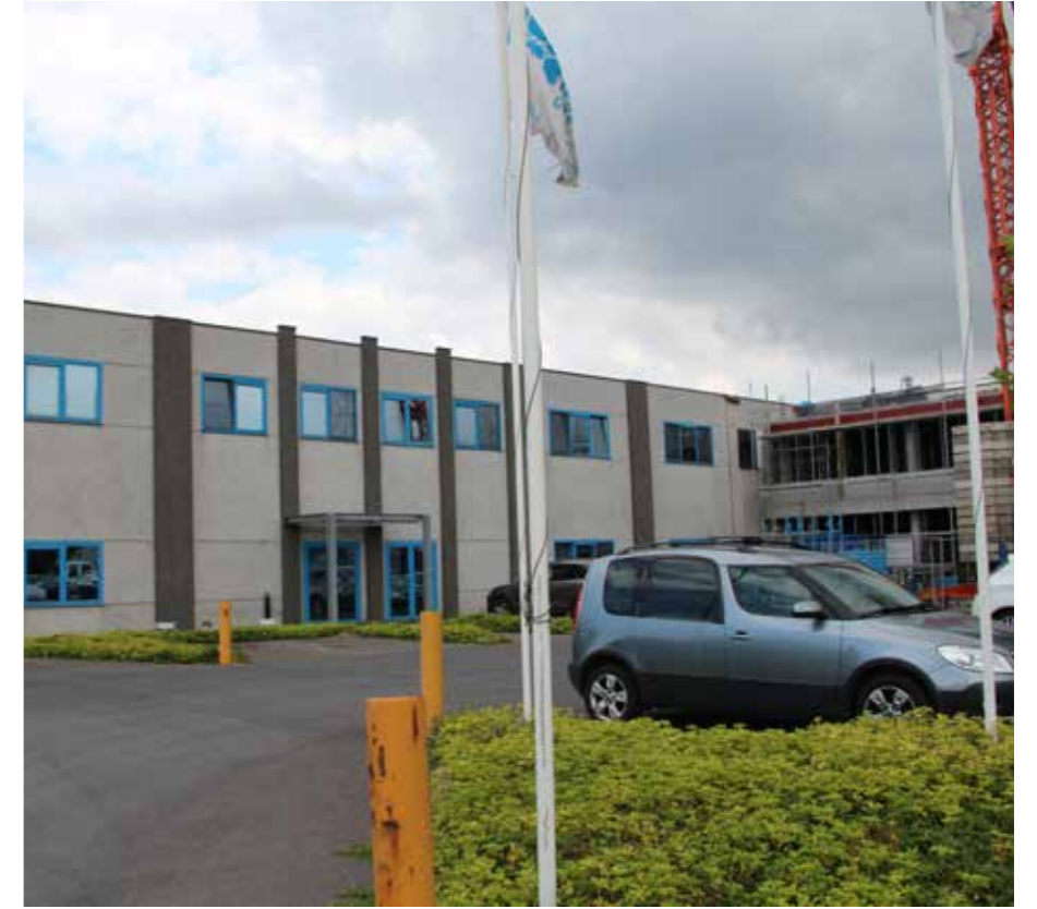
3. ZICHT OP HET OUDE KANTOORGEBOUW EN HET NIEUWE KANTOORGEBOUW
