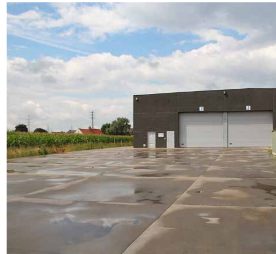
3. ZICHT OP DE OUDE LOODS
