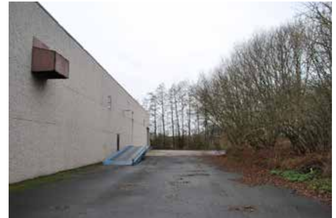
de achterzijde van de bedrijfsgebouwen
