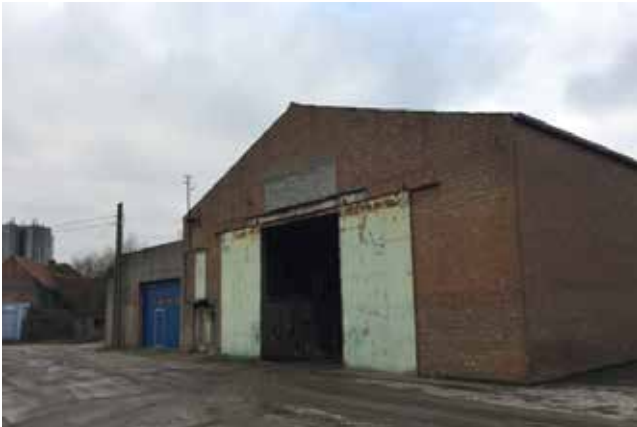
loods op de site van marcke
