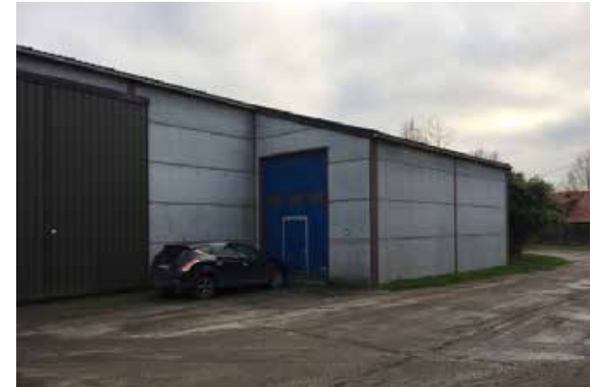
loods op de site van marcke
