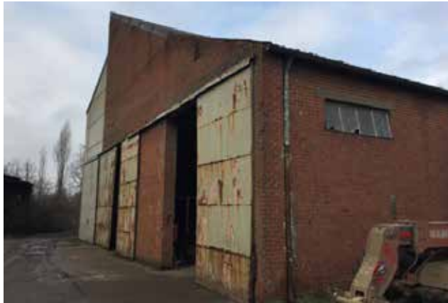
loods op de site van marcke
