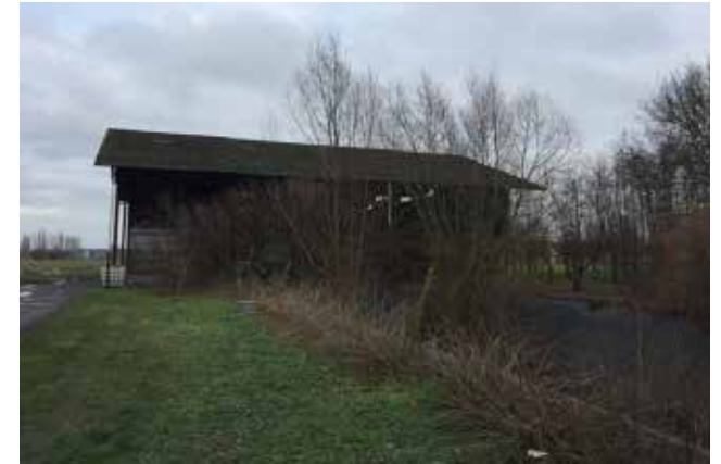
in het uiterste oosten van de site bevindt zich een groenbuffer, achterliggende loodsen worden niet in het RUP opgenomen
