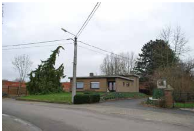
de zuidoostelijke hoek van het plangebied grenst met deze villa
