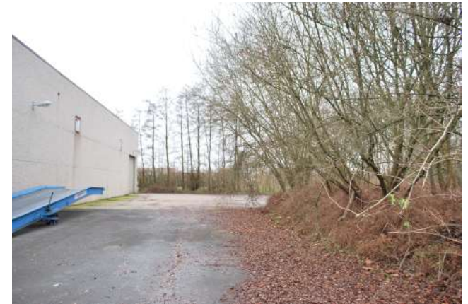
de achterzijde van de bedrijfsgebouwen
