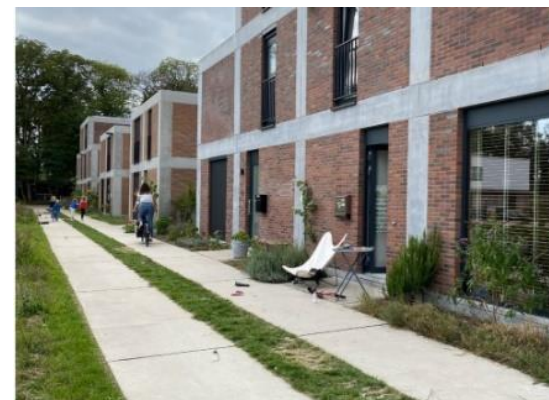
De karrensproen maken duidelijk dat de auto te gast is - Lijnmolenpark Gent - masterplan Omgeving
