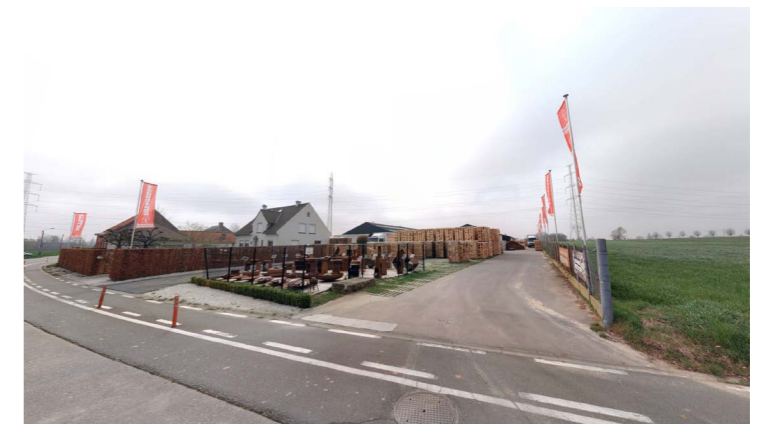
Site Demeyere gezien vanuit de Scheldestraat
