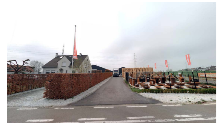
Site Demeyere gezien vanuit de Scheldestraat
