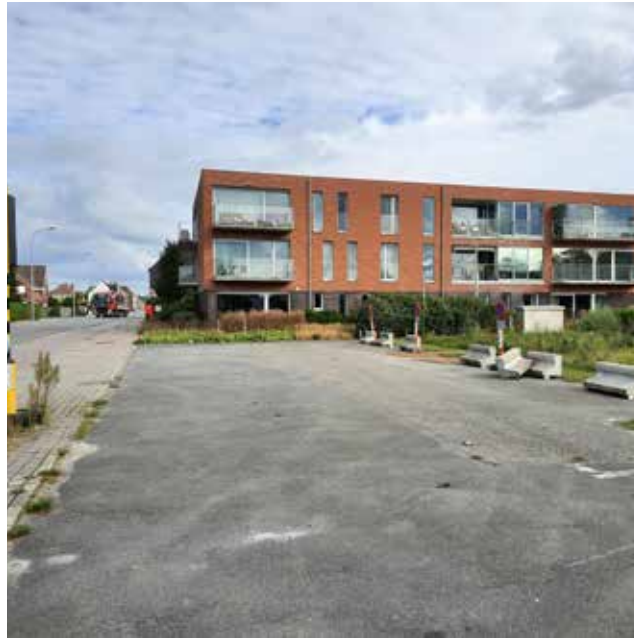
Sociaal wooncomplex ten oosten van de site (13/10/2021)
