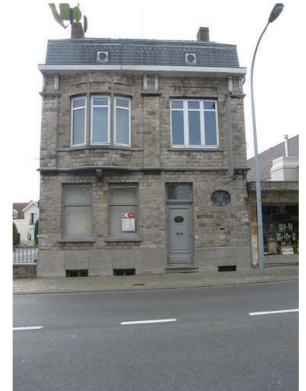
LUITENANT-GENERAAL GÉRARDSTRAAT 10: ONDERKELDERDE BURGERWONING (ERFGOEDWAARDE NIET MEER AANWEZIG)
