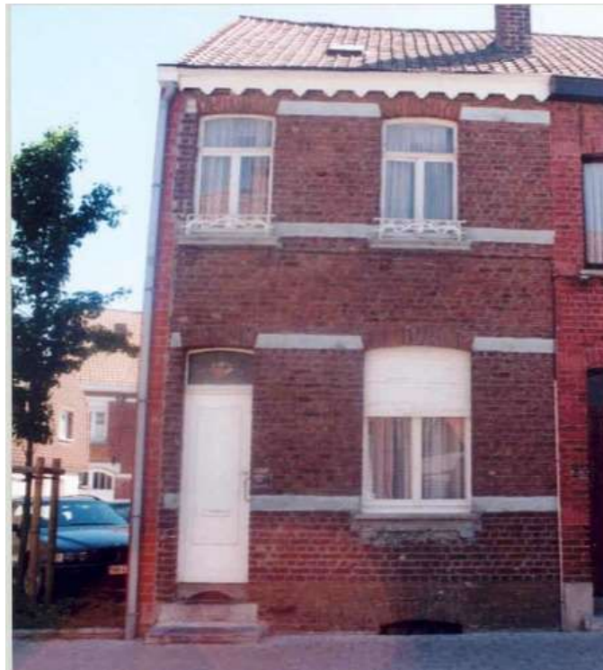
TWAALFDE-LINIESTRAAT 18: HALF VRIJSTAANDE DORPSWONING (ERFGOEDWAARDE NIET MEER AANWEZIG)
