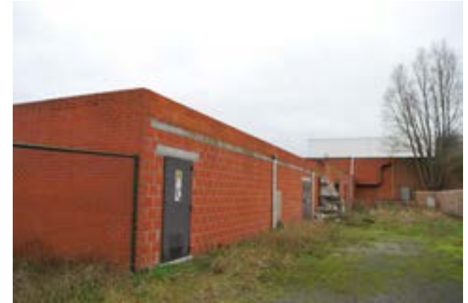
tussen een aangrenzende woning en de site bevindt zich een onverharde strook
