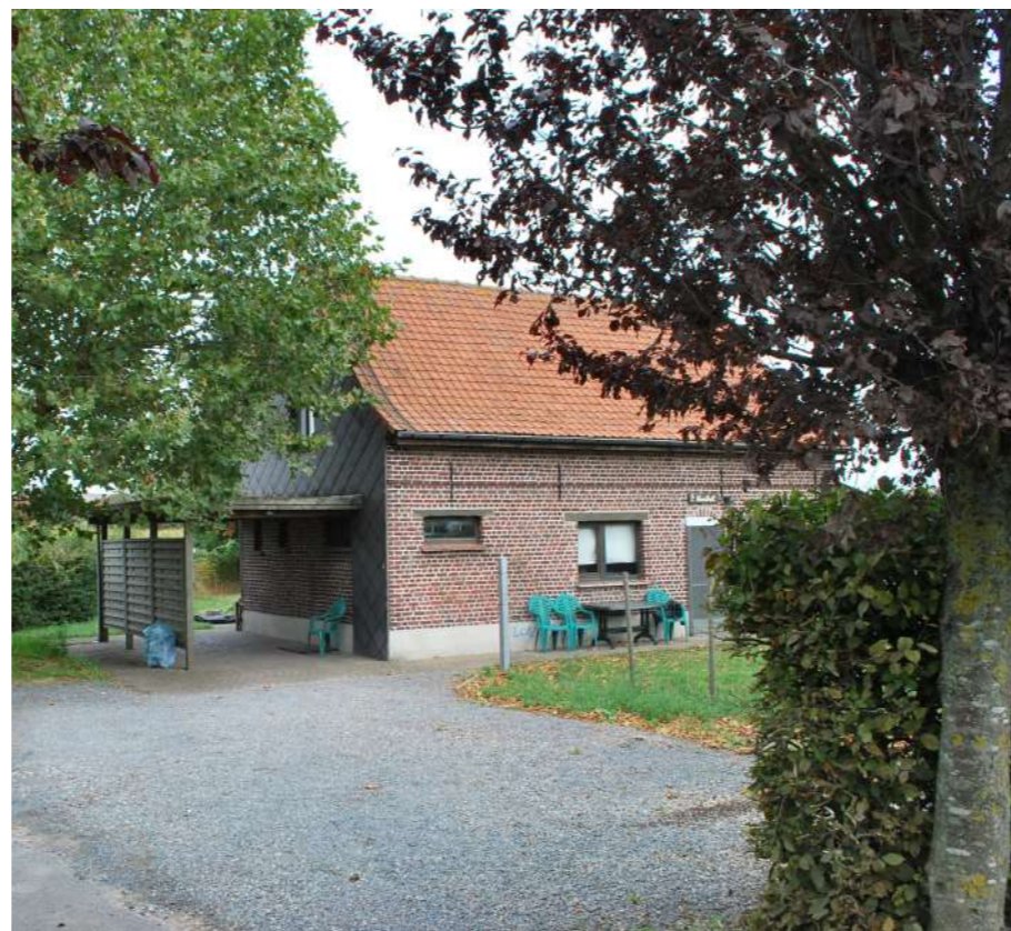
Geïsoleerde woning in het openruimtegebied
