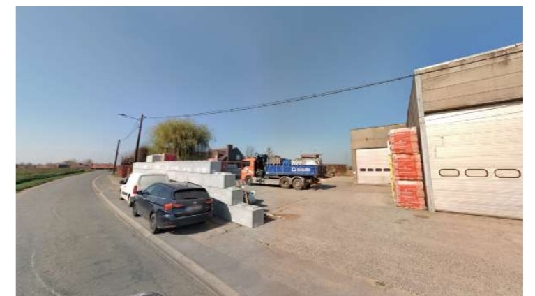
Site Poleyn gezien vanuit de Pontstraat
