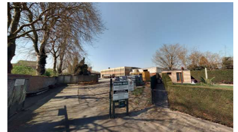
Site Recupal gezien vanuit de Moense Beekstraat
