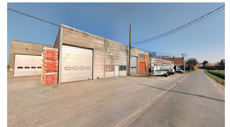
Site Poleyn gezien vanuit de Pontstraat
