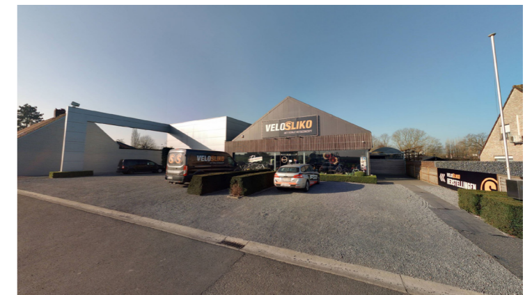
Site Velosliko gezien vanuit de Keiberg
