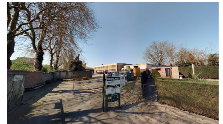
Site Recupal gezien vanuit de Moense Beekstraat
