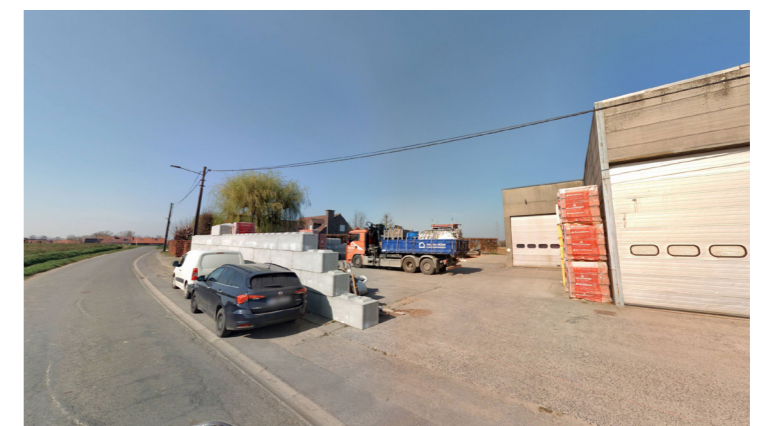
Site Poleyn gezien vanuit de Pontstraat
