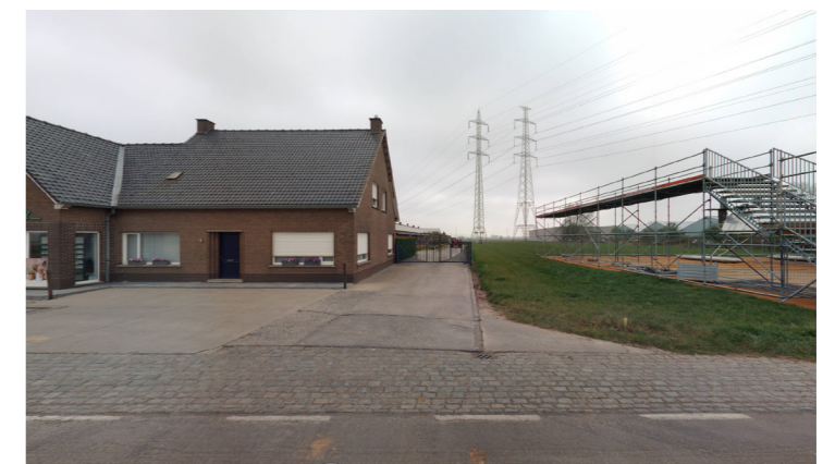
Site Tuin & hobby Dewitte gezien vanuit de Tiegemstraat
