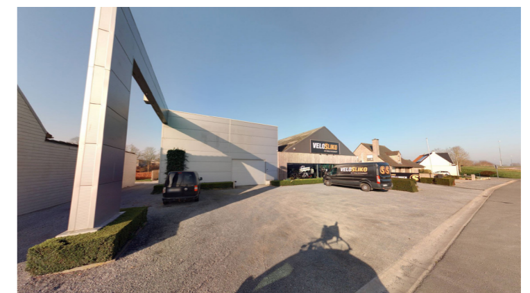
Site Velosliko gezien vanuit de Keiberg
