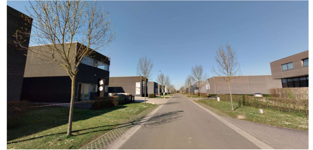
Referentie Straatbeeld bedrijventerrein - Esserstraat
