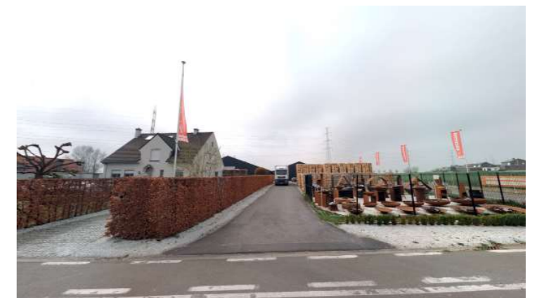
Site Demeyere gezien vanuit de Scheldestraat
