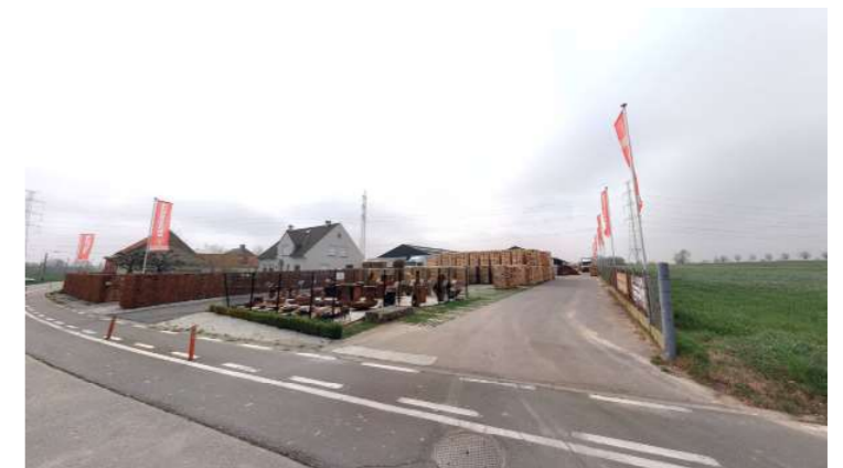
Site Demeyere gezien vanuit de Scheldestraat
