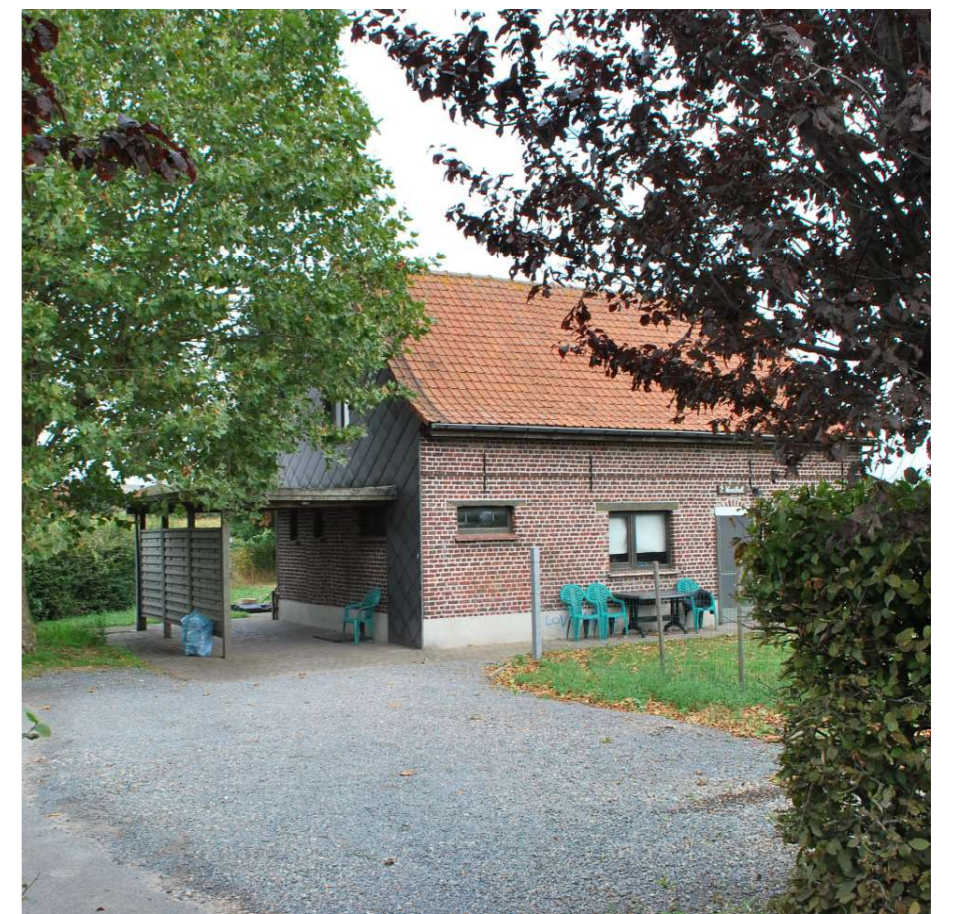
Geïsoleerde woning in het openruimtegebied
