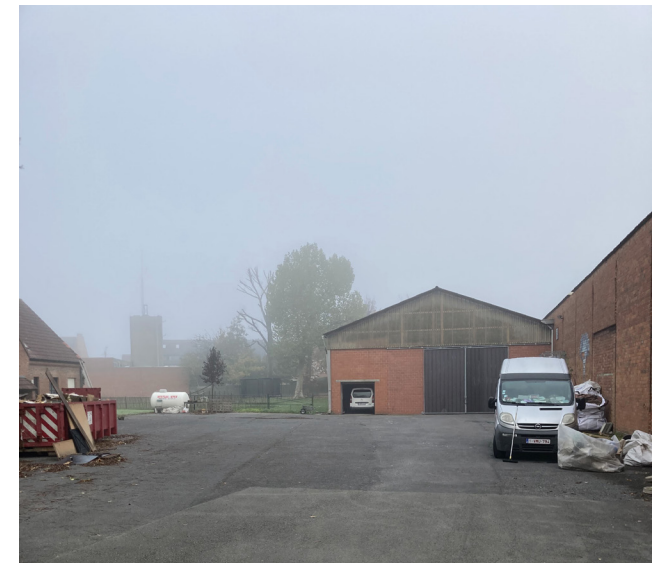
Zicht op binnengebied naast industriële loodsen
