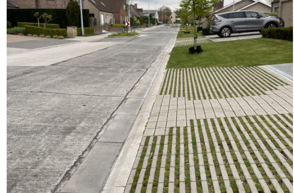
Foto 10: referentiebeeld: ontharding oprit - parking
