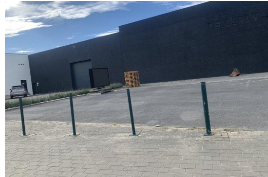
Foto 5: eigen beeld: in-en uitrit beperkt door plaatsen palen
