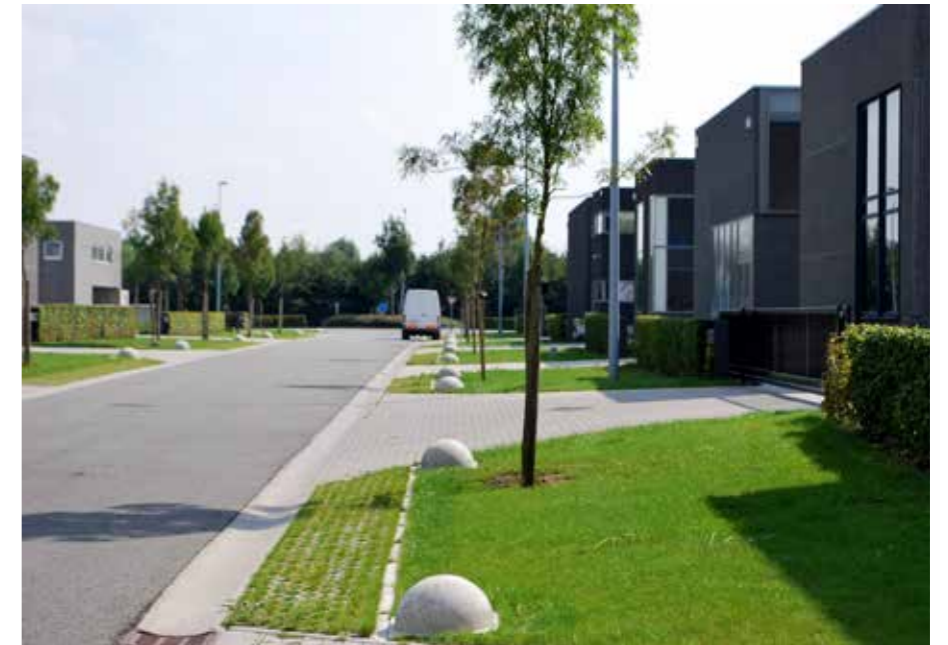
Referentie veilige toegangen - Bedrijventerrein Esserstraat Zwevegem (© Intercommunale Leiedal)
