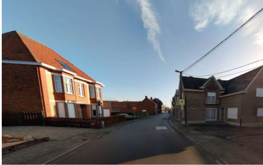
ONDERGRONDSE BARMBEEK TER HOOGTE VAN GROTE HEERWEG
