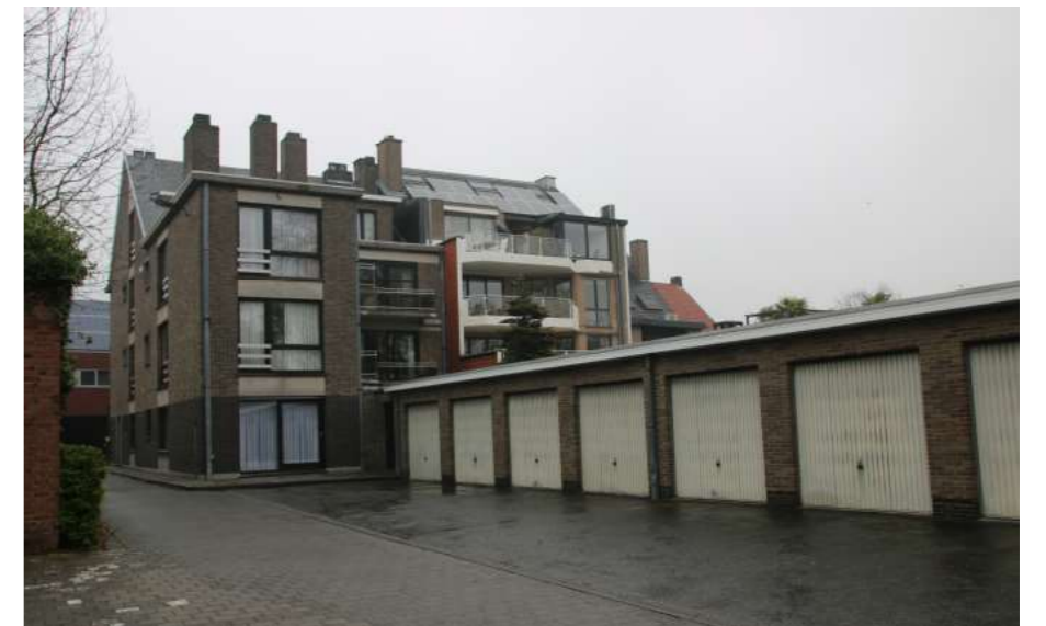
LIEBAARDSTRAAT – APPARTEMENTISERING ACHTERKANT
