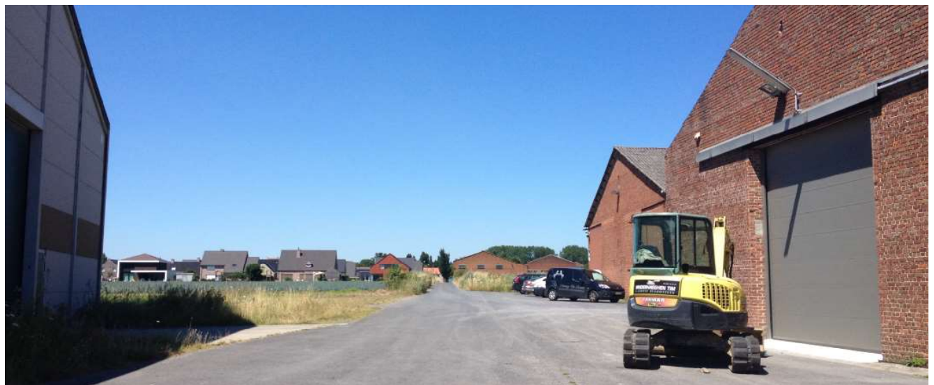
ZICHT OP DE LOODSEN EN ACHTERLIGGENDE BEBOUWING
