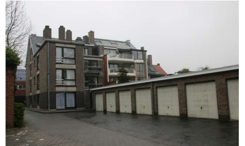
LIEBAARDSTRAAT - TOEGANG TOT GARAGES IN 2DE BOUWLIJN
