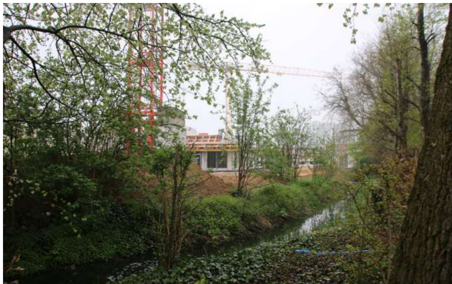
BARMBEEK TER HOOGTE VAN DE MOTE
