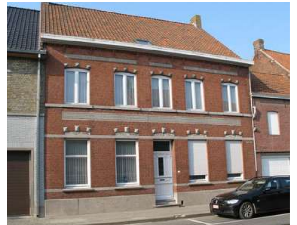
VLASSERSWONING IN LIEBAARDSTRAAT - ID 208572
