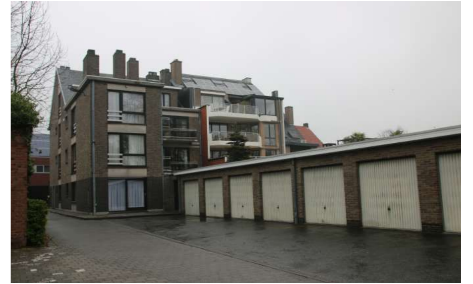
LIEBAARDSTRAAT - TOEGANG TOT GARAGES IN 2DE BOUWLIJN
