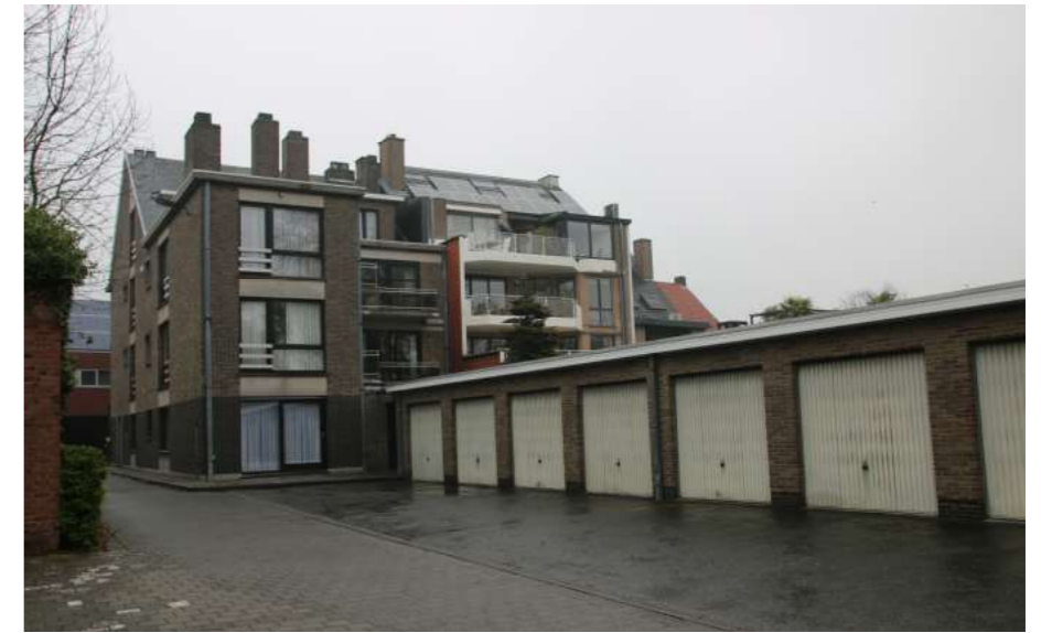
LIEBAARDSTRAAT – APPARTEMENTISERING ACHTERKANT
