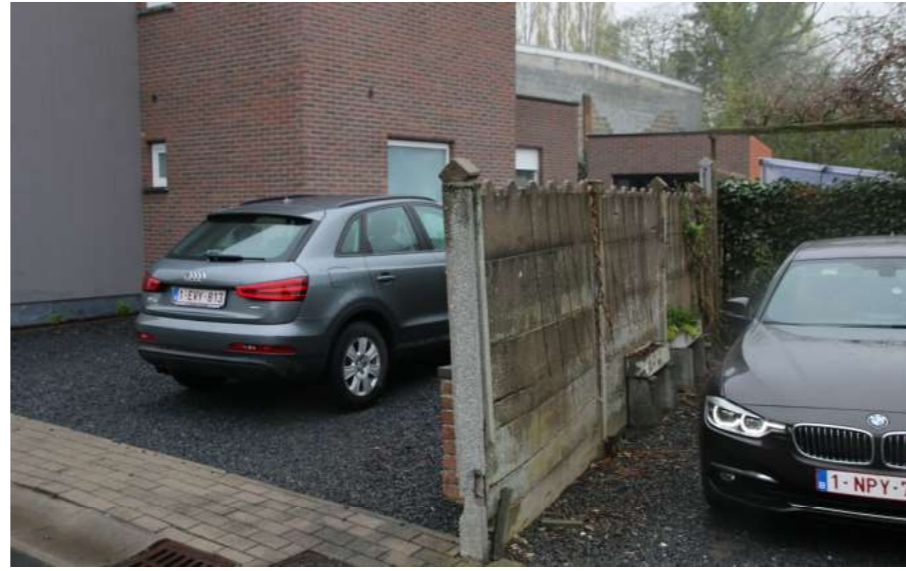
ONDERGRONDSE BARMBEEK TER HOOGTE VAN KLEINE LIEBAARDSTRAAT
