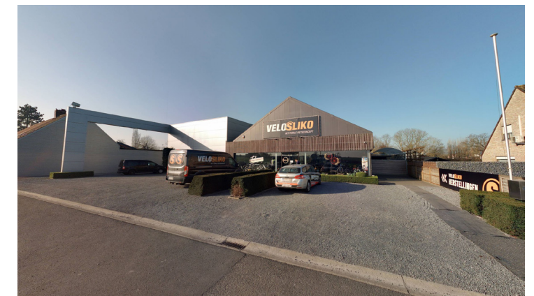
Site Velosliko gezien vanuit de Keiberg
