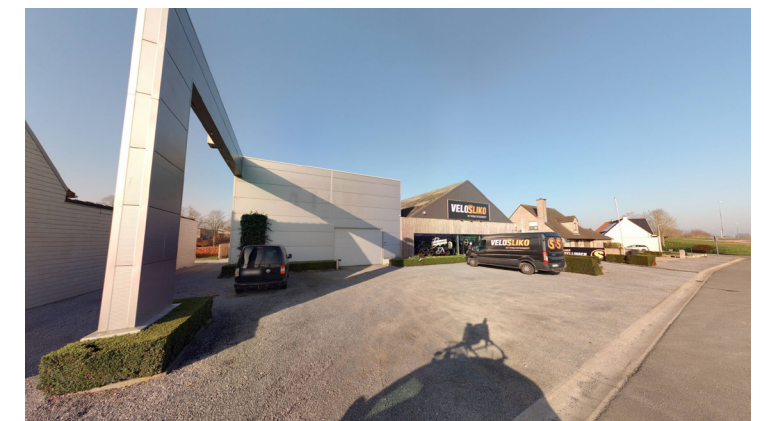
Site Velosliko gezien vanuit de Keiberg
